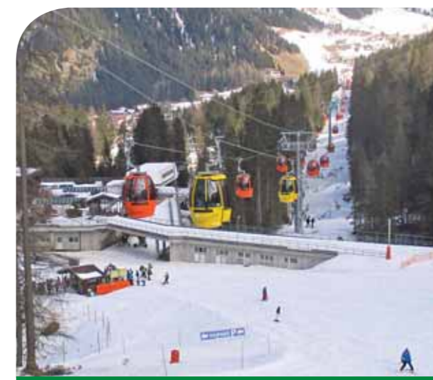
La lift nü Borest che colieia Corvara y Calfosch
