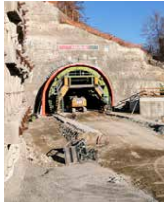
Das Westportal der Umfahrung
