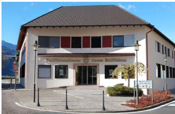
Neu gestalteter Sitz der Raiffeisenkasse Terlan im November 2007
