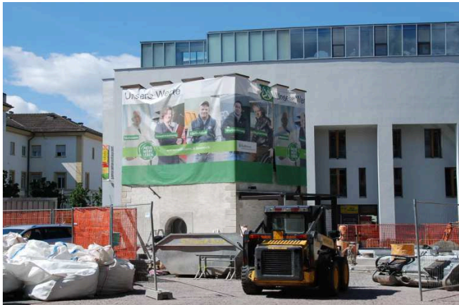
Abbildung 9: Pulverturm beim Umbau
