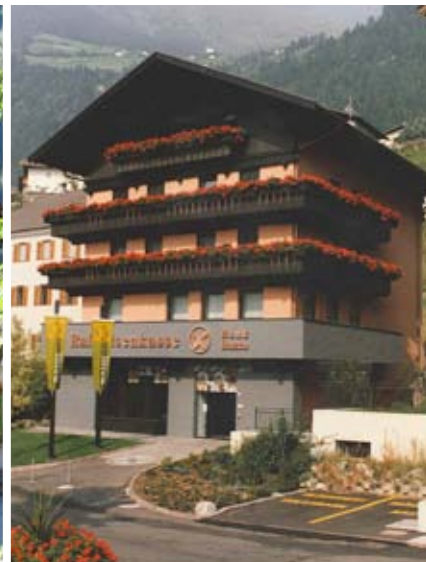
Umbau Sitz St. Leonhard 1987
